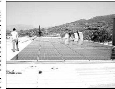
Operarios trabajan en la colocación de las placas.
