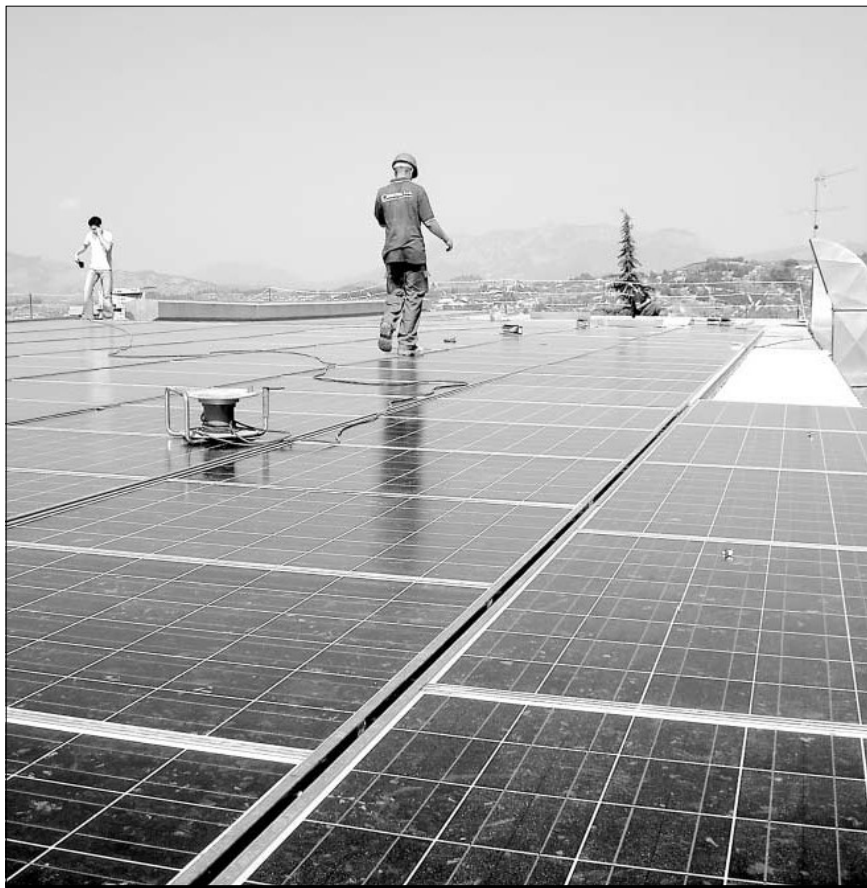
La instalación de paneles fotovoltaicos sobre la cubierta de Transportes Cotes Baixes.
