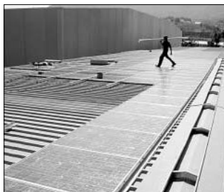
Instalación de los paneles.
